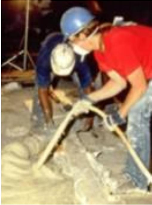
La amplitud y la frecuencia son factores muy importantes a la hora de seleccionar el vibrador mas adecuado para la instalación de sus refractarios .
